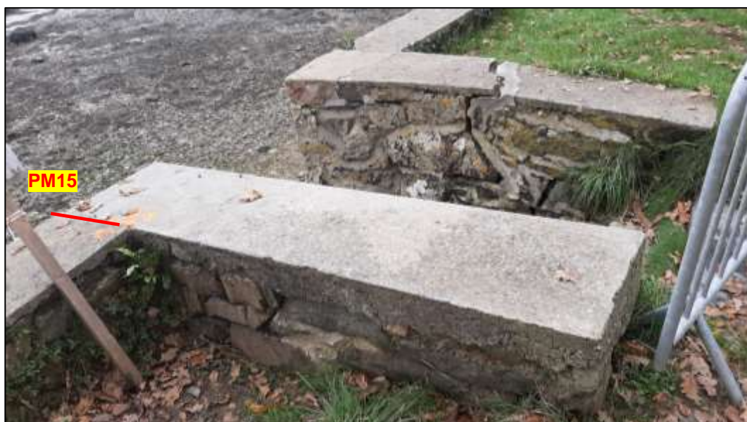
Basculement de l'escalier Ouest. Fracture très nette au niveau d'une reprise plus ou moins récente.
