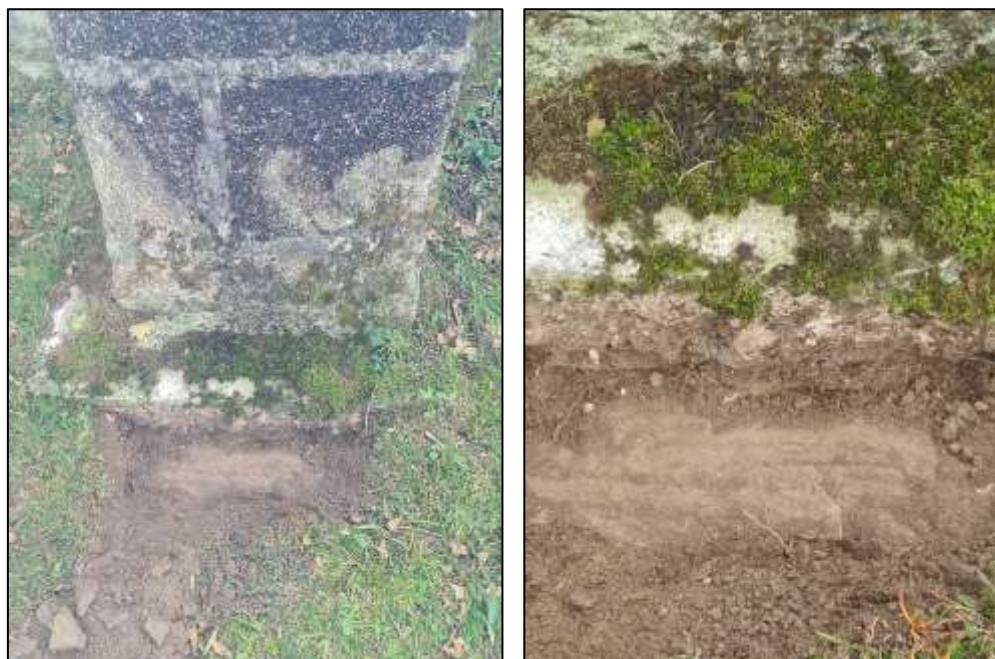
Photographies du sondage RF6 – Une poutre béton de faible section ceinture l pied de mur de la Chapelle. Le schiste gréseux ou un bloc schisteux a rapidement limité la profondeur d'investigation par moyens manuels. Le sondage a pu être descendu à 0.15 m.
