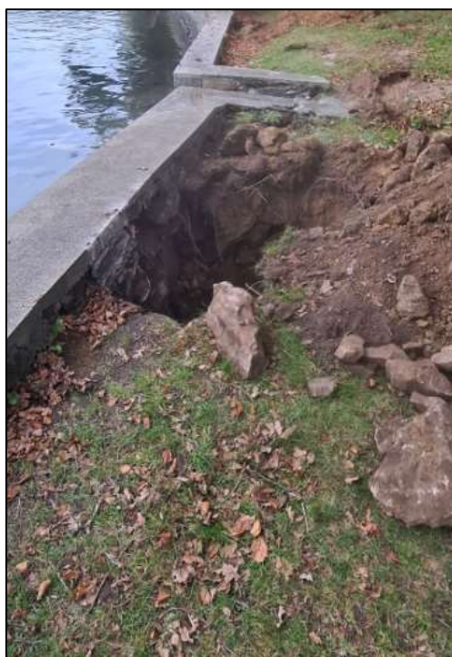
Photographies du sondage RF3 – Le mur a une hauteur encastrée de 1.7 m. A noter également ici la présence de gros blocs dans le remblai amont.
