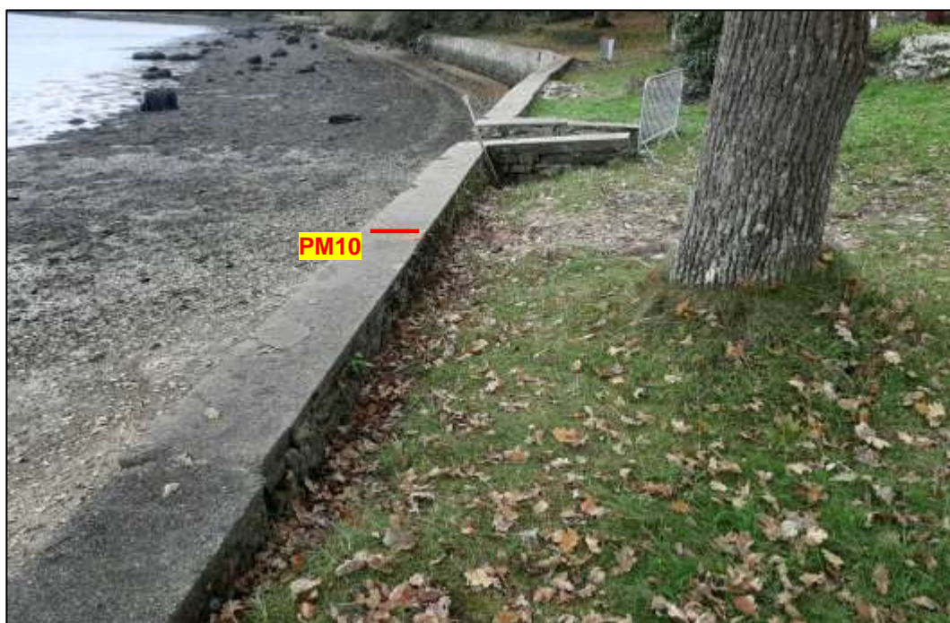
Basculement du mur depuis \approx PM7 jusqu'à l'escalier Ouest. Fracture nette entre les 2 portions de mur. Dépression et fissures de traction dans le terrain amont.
