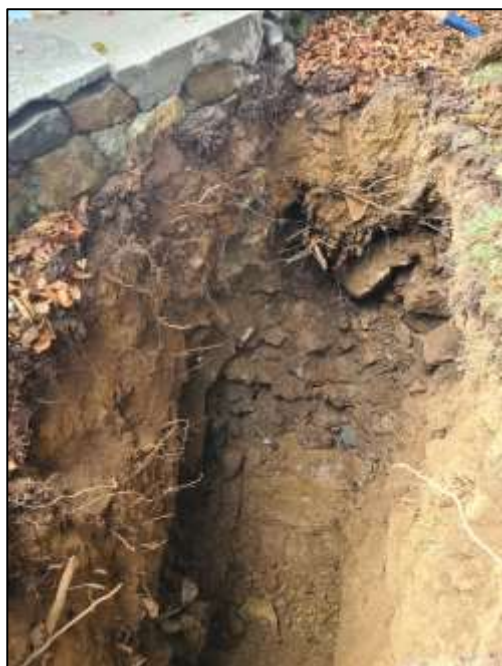
Photographies du sondage RF4 – Le mur a une hauteur encastrée de 1.6 m. Pas d'amélioration significative de la structure de la maçonnerie par rapport à la moitié Ouest.
