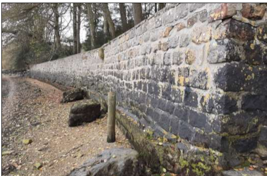
Vue générale du mur Est, au-delà de PM45. Quelques fissures sont visibles mais l'état global est sensiblement meilleur qu'à l'Ouest.
