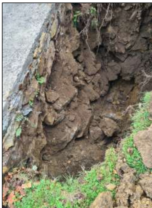
Photographies du sondage RF2 – Le mur a une hauteur encastrée de 1.8 m. A noter la présence de gros blocs dans le remblai amont.
