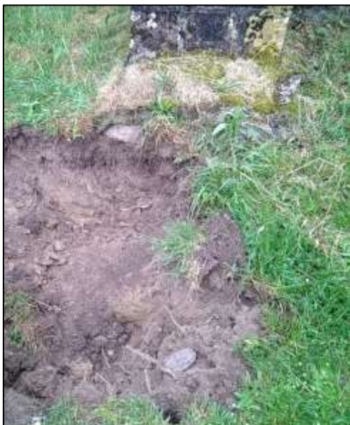
Photographies du sondage RF5 – Une poutre béton de faible section ceinture le pied de mur de la Chapelle. Le prolongement du sondage montre ensuite une absence de fondation pour ce « contrefort » en angle de Chapelle. Des terrains de compacité faible et poreux ont été mis en évidence en-dessous.
