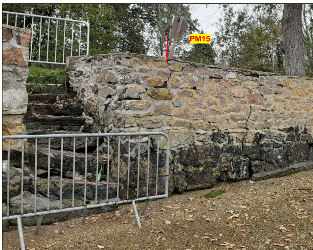
Secteur PM15 – Basculement du mur et des murs latéraux de l'escalier. Fissures et fractures. Affouillement du mur
