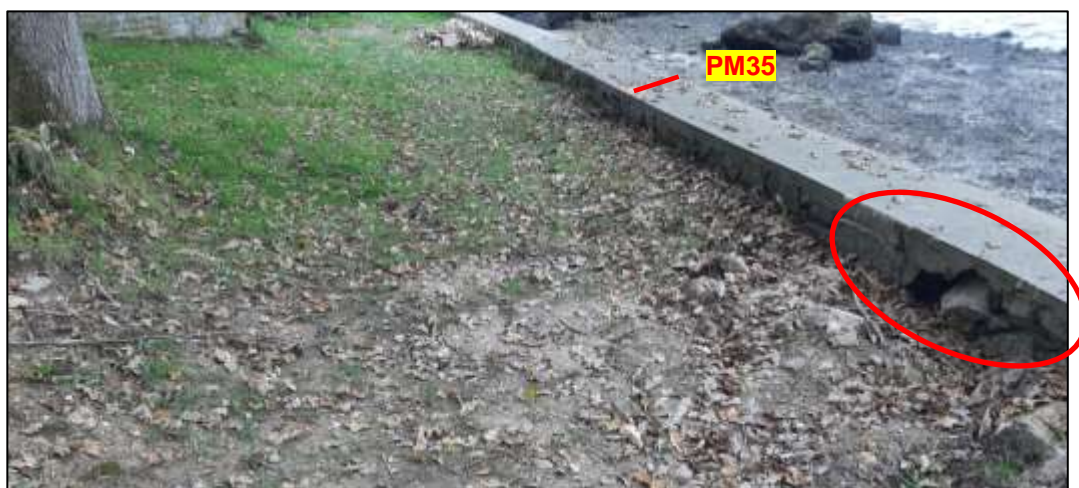
Blocs disjointoyés côté terre à proximité de PM40.
