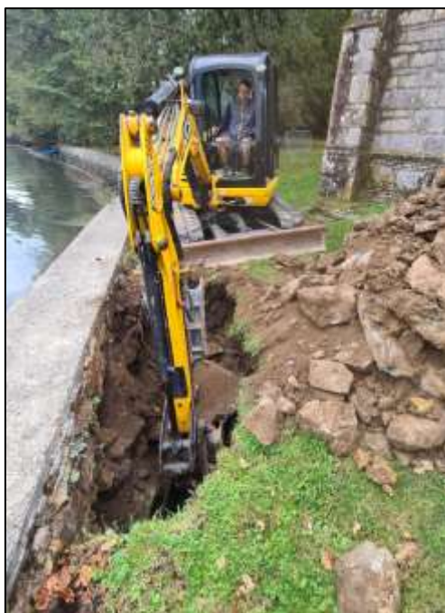
Photographies du sondage RF2 – Le mur a une hauteur encastrée de 1.8 m. A noter la présence de gros blocs dans le remblai amont.
