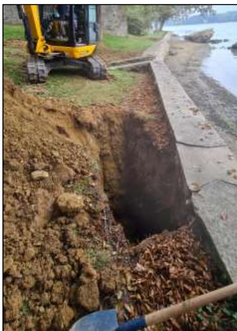
Photographies du sondage RF4 – Le mur a une hauteur encastrée de 1.6 m. Pas d'amélioration significative de la structure de la maçonnerie par rapport à la moitié Ouest.
