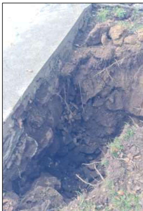
Photographies du sondage RF3 – Le mur a une hauteur encastrée de 1.7 m. A noter également ici la présence de gros blocs dans le remblai amont.
