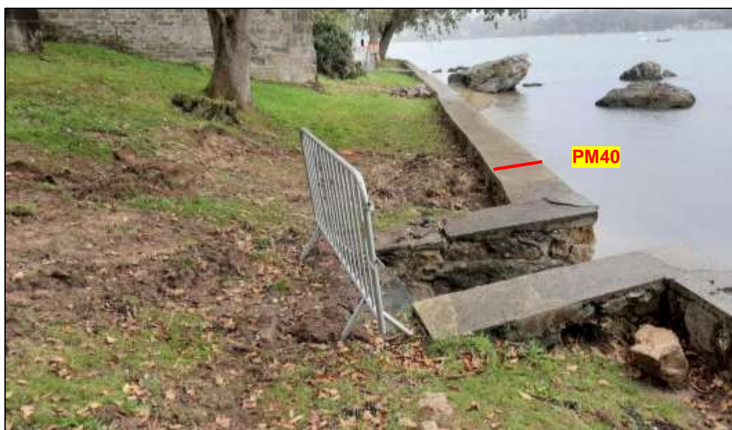
Décrochement de l'escalier « central », à l'instar de l'escalier Ouest.
