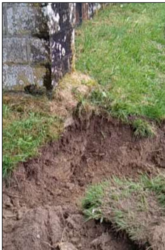
Photographies du sondage RF5 – Une poutre béton de faible section ceinture le pied de mur de la Chapelle. Le prolongement du sondage montre ensuite une absence de fondation pour ce « contrefort » en angle de Chapelle. Des terrains de compacité faible et poreux ont été mis en évidence en-dessous.
