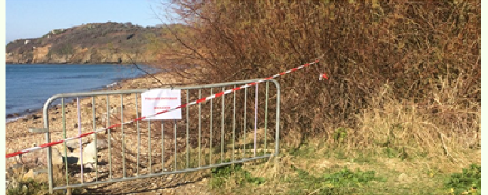
état dégradé du sentier
