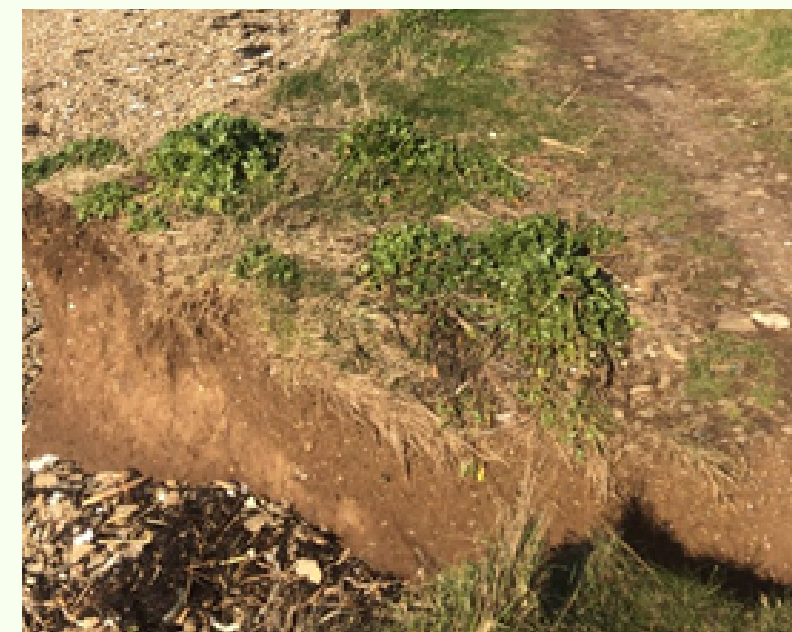
état dégradé du sentier
