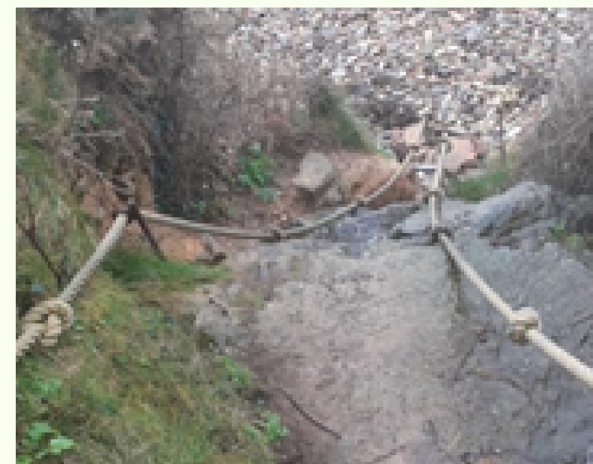
accès à la grève du Corbeau
