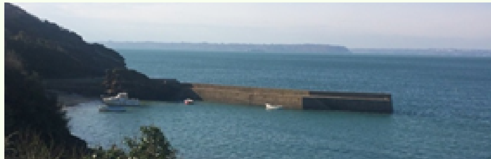
vue sur la digue de Porz Meur
