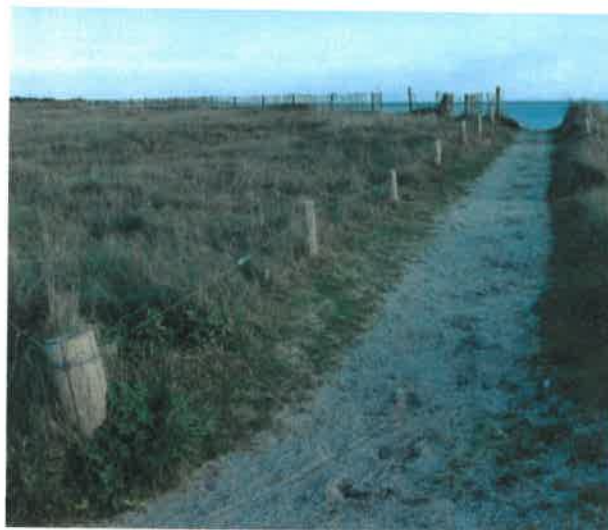
Poteaux en robinier et monofil galvanisé
