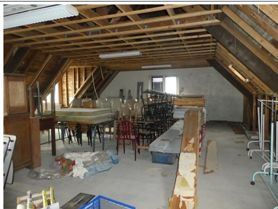
Pièce mansardée (3 ème étage)
