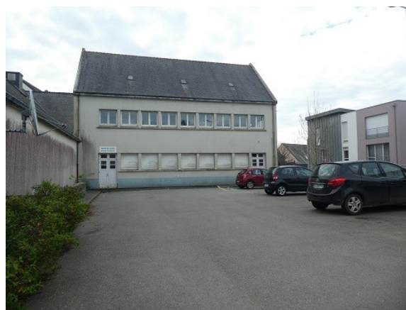
Façade arrière Maison des Oeuvres
